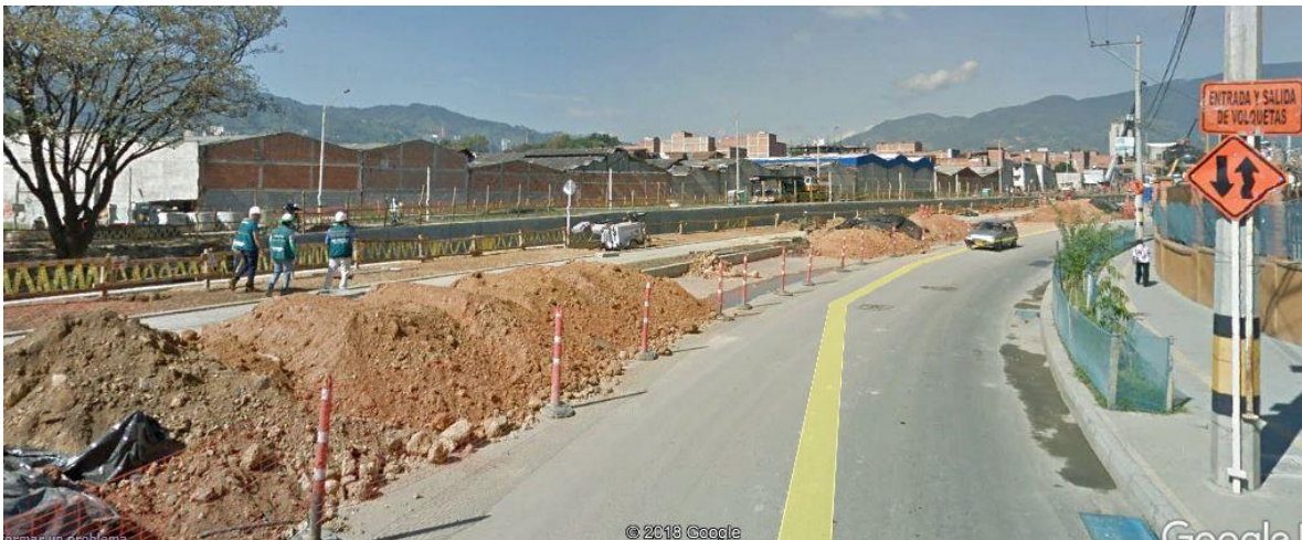
Foto: Avances en la construcción de la obra del Metroplús. Tomada de: Google Earth
